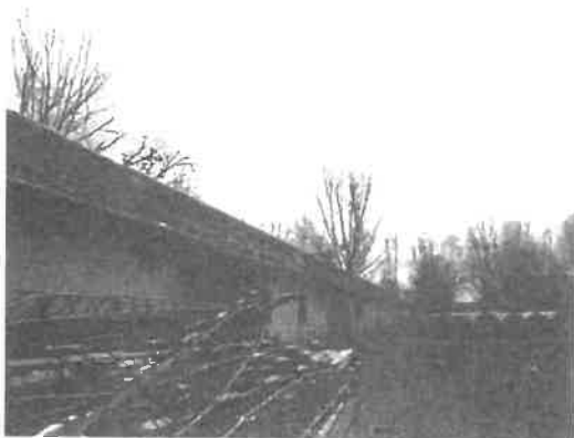
6.sz.kép: 3-as jelű északi homlokzat
