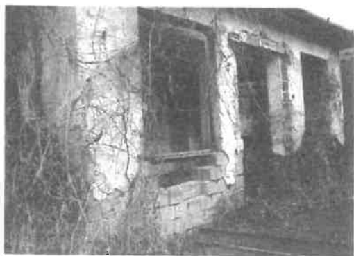
1.sz. kép: 1-es jelű épület.
