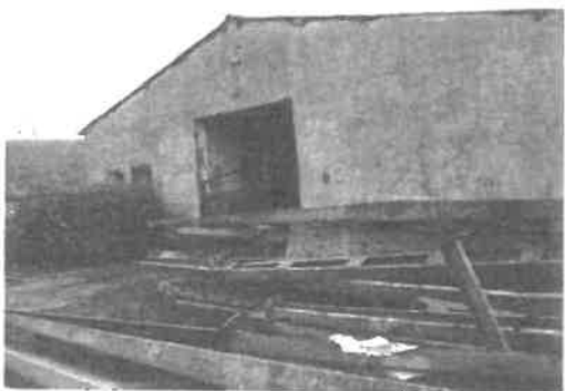
3.sz.kép: 2-es jelű északi homlokzat részlet
